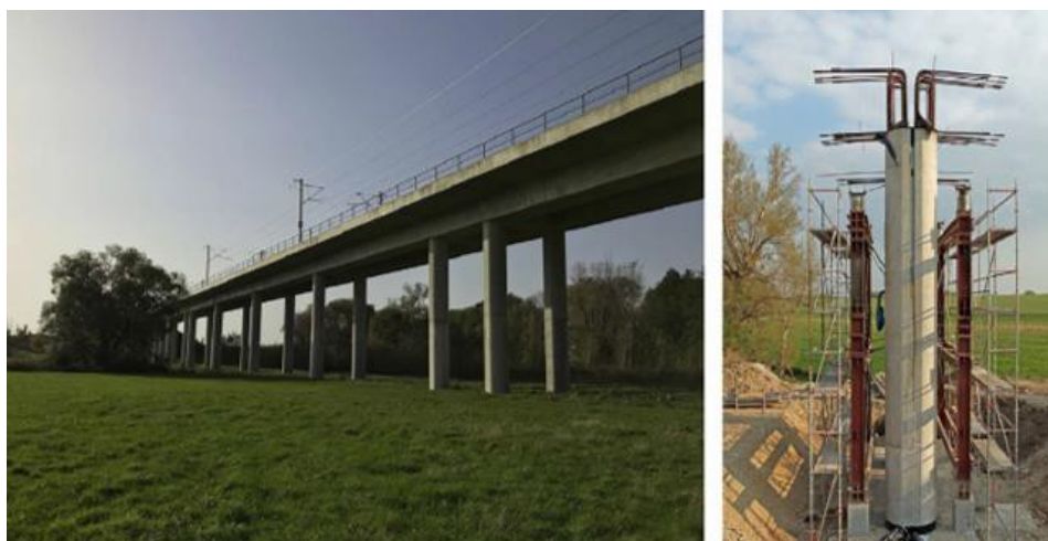
Figur 24. Broförlagd höghastighetsbanan ger minimalt markarbete.
