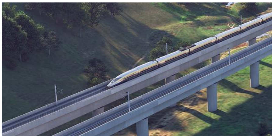
Figur 25. Broförlagda banor skyddar höghastighetsbanan mot snödriv.
